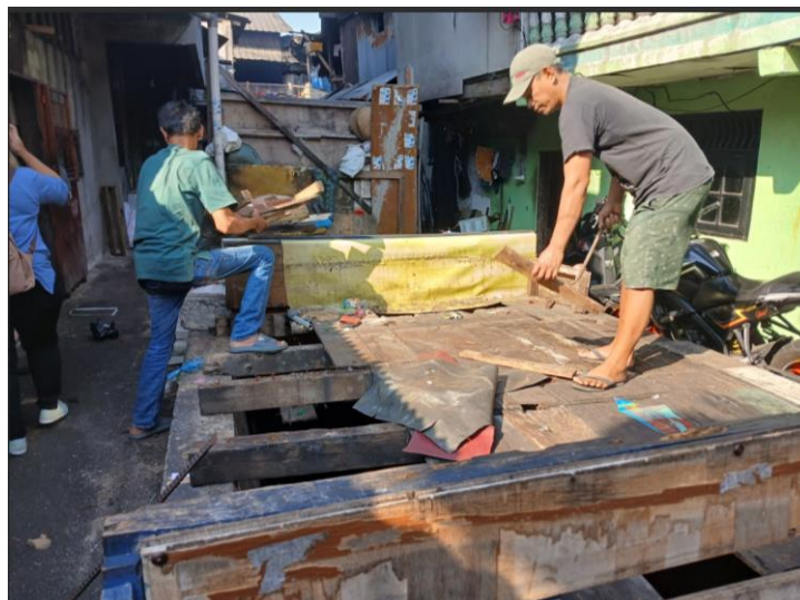
Gambar 9. Proses Pembersihan dan Persiapan Site di Kampung Rawa (Sumber: Dokumentasi Pribadi, 2024)
