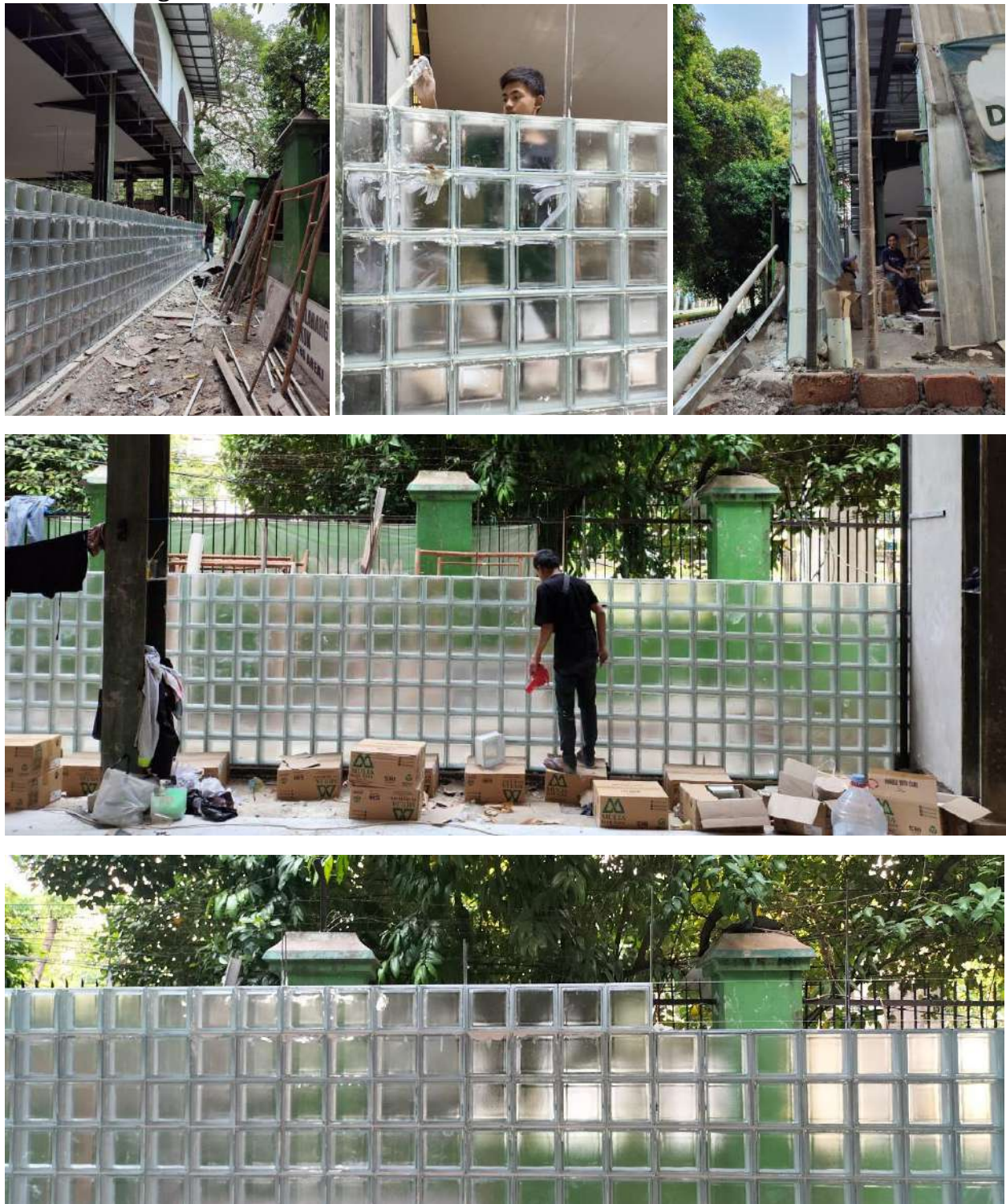
Gambar 3. Proses Pekerjaan Dinding Glass Box pada Lantai 1 sampai Minggu Kedua Juli 2024
