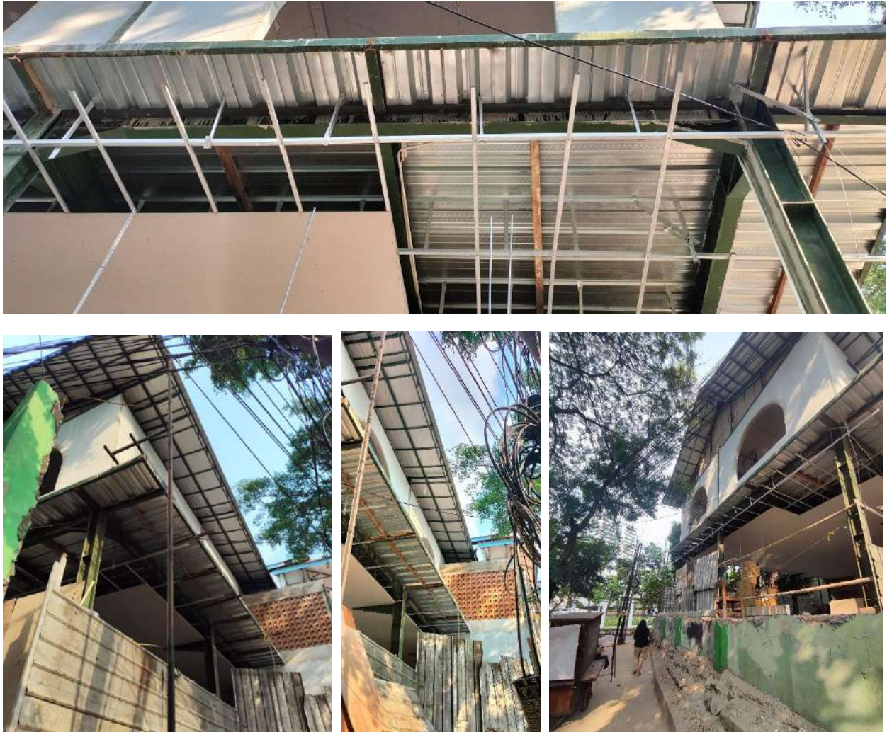
Gambar 14. Proses Pekerjaan Rangka Plafon Sisi Luar Lantai 1 dan 2
