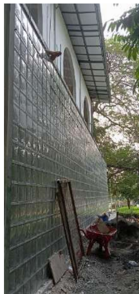
Gambar 5. Proses Pekerjaan Dinding Glass Box pada Lantai 1 sampai Minggu Keempat Juli 2024
