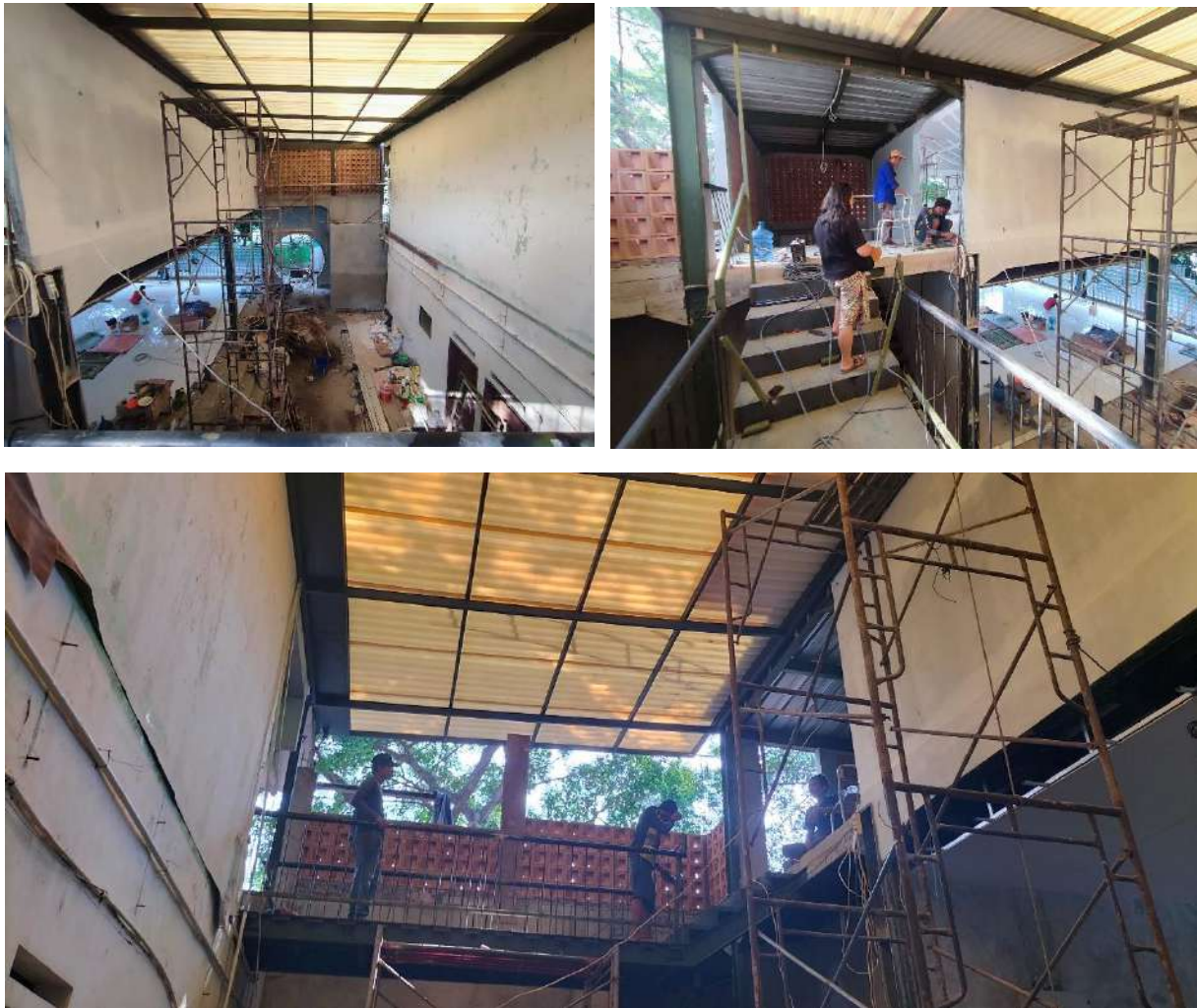
Gambar 19. Proses Pekerjaan Rangka dan Penutup Atap Penghubung Bangunan Existing dengan Masjid
