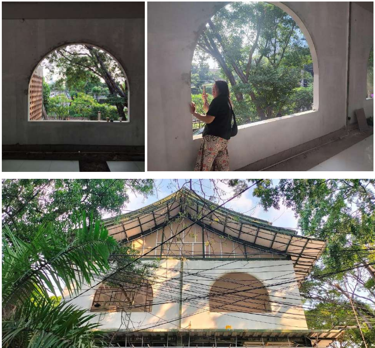
Gambar 21. Proses Pekerjaan Bukaan (Jendela) pada Lantai 1
