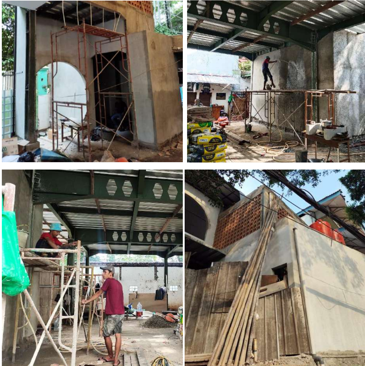
Gambar 2. Proses Pekerjaan Dinding Bata di Lantai 1
