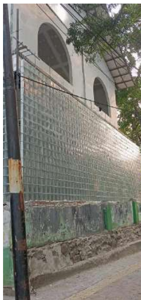
Gambar 5. Proses Pekerjaan Dinding Glass Box pada Lantai 1 sampai Minggu Keempat Juli 2024
