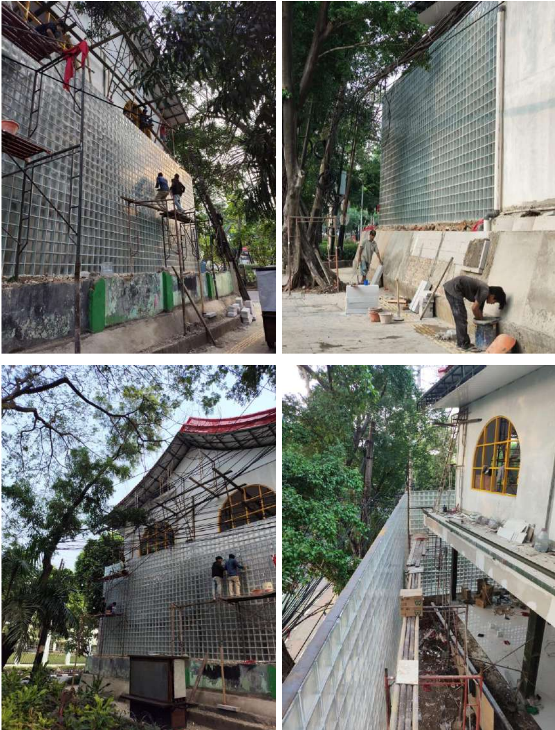
Gambar 6. Proses Pekerjaan Dinding Glass Box pada Lantai 1 sampai Minggu Kedua Agustus 2024
