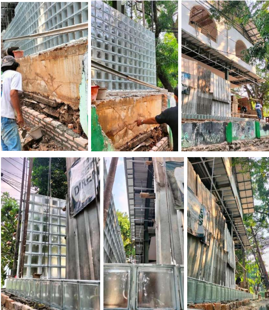
Gambar 23. Proses Pekerjaan Pagar Glass Box
