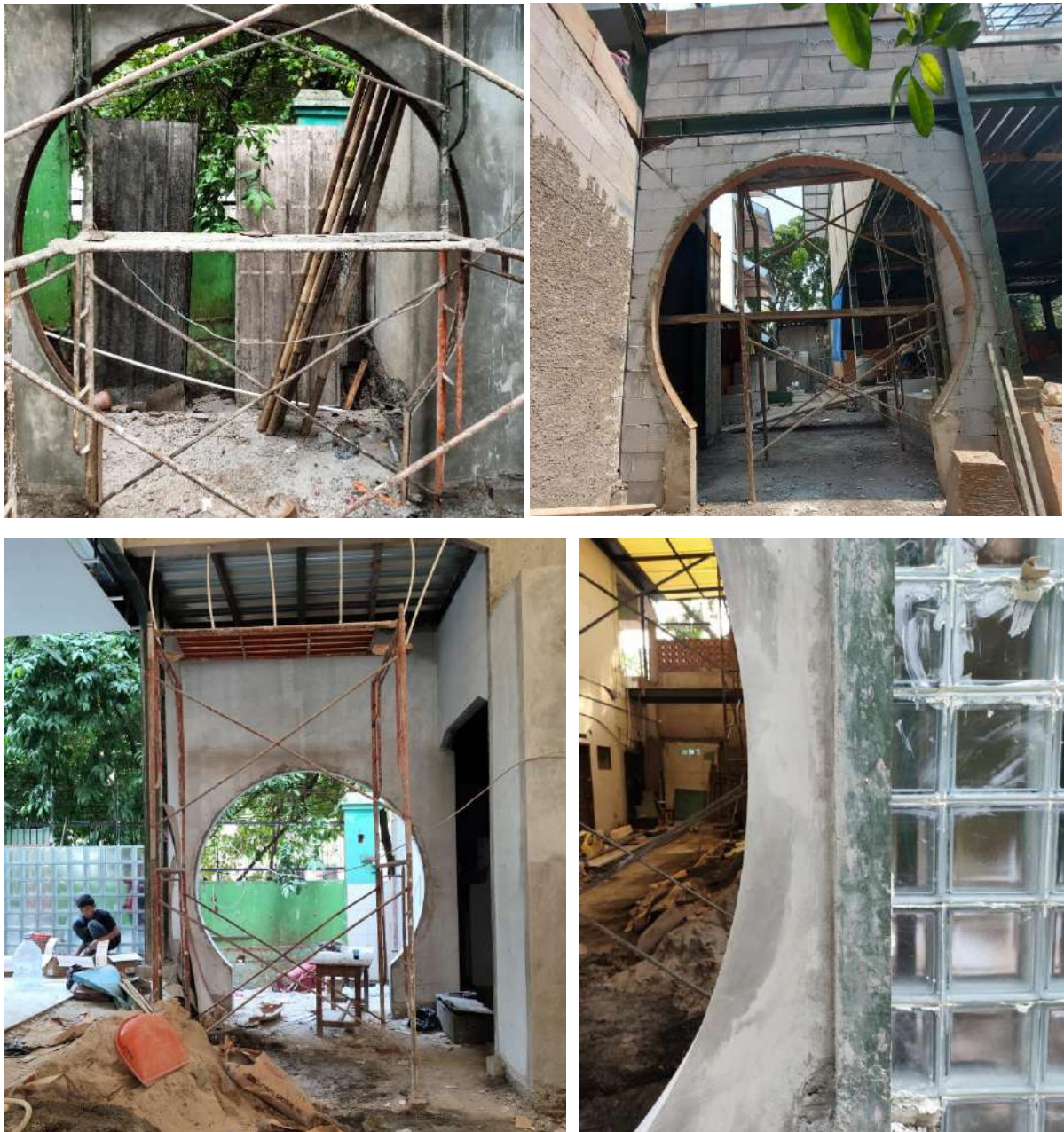
Gambar 20. Proses Pekerjaan Buka pada Lantai 1
