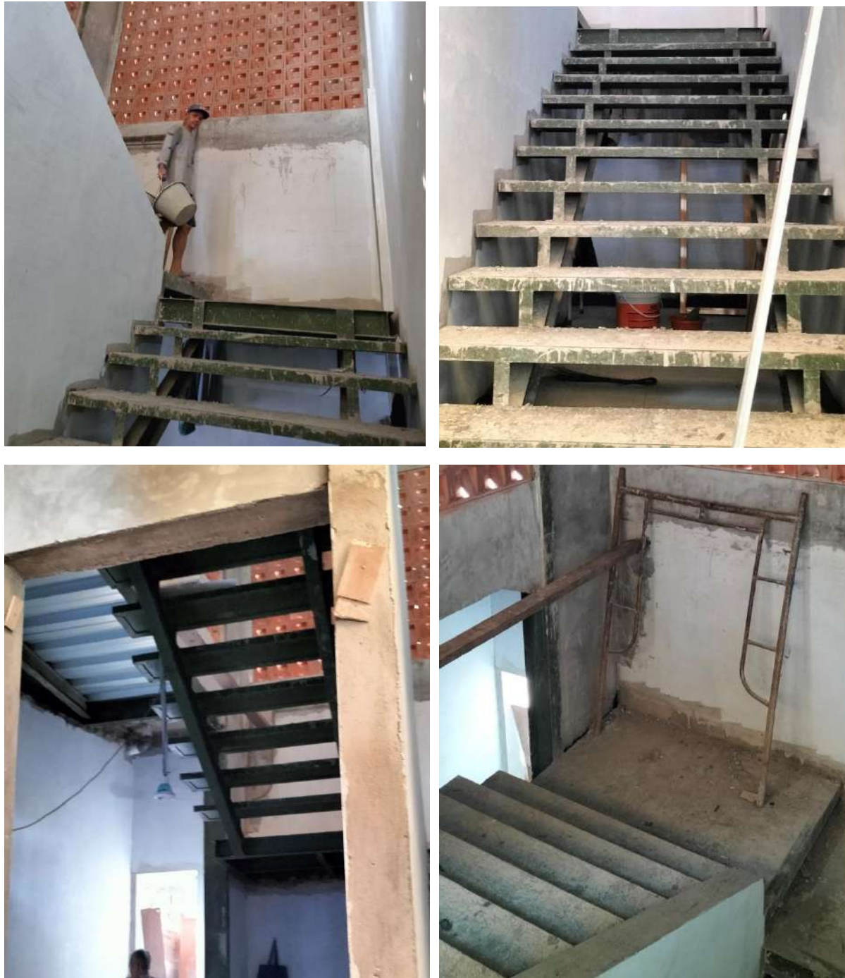
Gambar 26. Proses Pekerjaan Tangga
