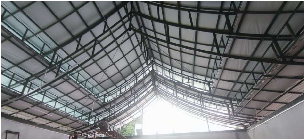
Gambar 15. Proses Pekerjaan Rangka Plafon Dalam Lantai 1 dan 2
