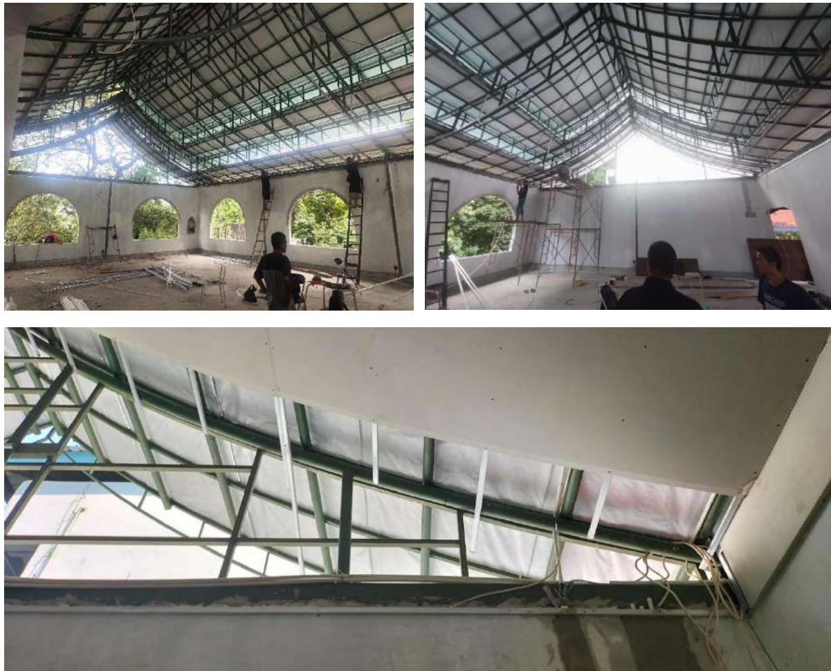
Gambar 18. Rangka Atap Lantai 2
