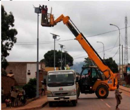
Gambar 3. Aplikasi Teknologi Photovoltaic dalam Sistem Penerangan Jalan di Kota Cumbia, Australia (Orejon-Sanchez, Andres-Diaz, & Gago-Calderon, 2021)
