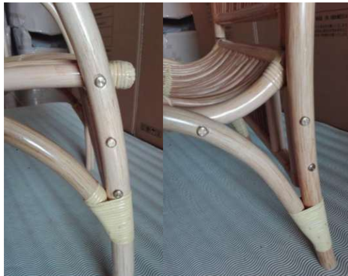
Gambar 5. 28 Aplikasi connector nuts pada joint connector bolts (JCB) yang diterapkan pada kursi rotan.
