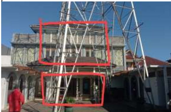
Sinkronitas modul fasade masjid hasil renovasi dengan modul teras masjid. Bentuk atap kanopi teras menutupi unit jendela pada lantai atas, dan mengaburkan aksentuasi pada fasade
