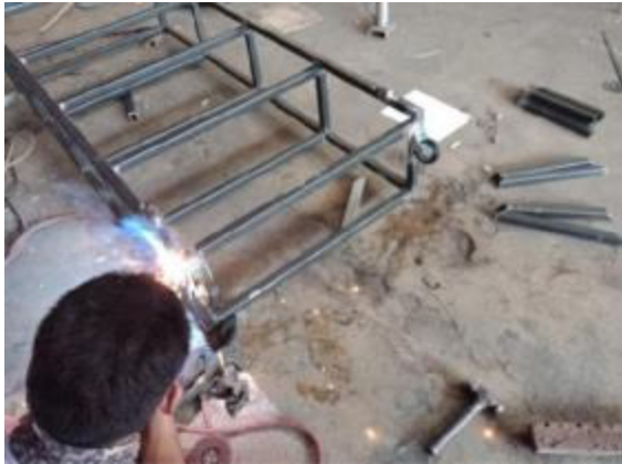
Gambar 16. Pemasangan roda dengan sambungan las Sumber: Sukania et al. (2020)
