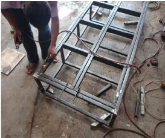
Gambar 12. Pemasangan engsel pintu Sumber: Sukania et al. (2020)
