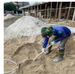
Gambar 5. Aktivitas Pekerja 4 Saat Memasukkan Pasir ke dalam Campuran Semen
