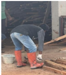
Gambar 2. Aktivitas Pekerja 1 Saat Melakukan Pencabutan Paku pada Balok Kayu
