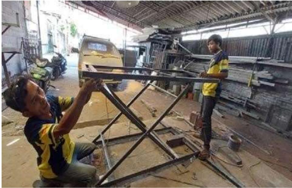
Gambar 30. Perakitan Rangka Utama dan Rangka Pengangkat.
