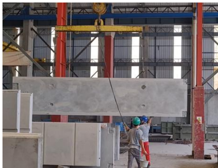
Gambar 8. Pemandangan Precast dengan Crane
