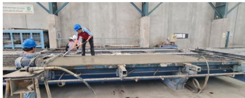
Gambar 5. Pemerataan permukaan precast
