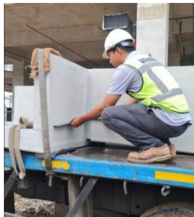
Gambar 11. Precast dilakukan pemeriksaan ukuran
