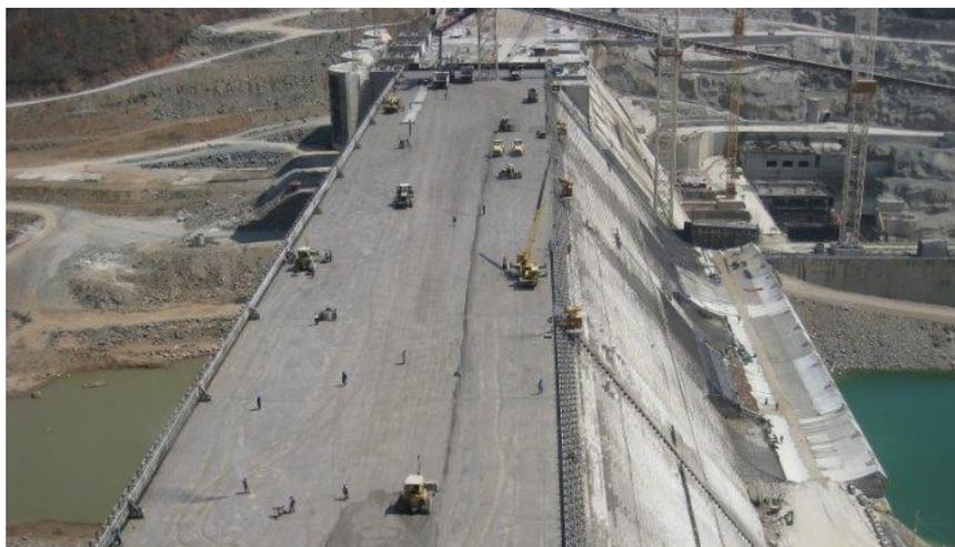
Gambar 5.1. *Mass Concrete* pada bendungan [7]
