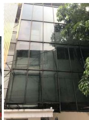
Gambar 6. Fasad di Arah Selatan Sumber: Dokumentasi Penulis, 2022
