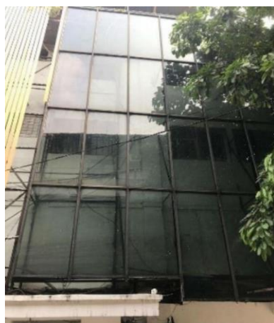
Gambar 4. Tampak Belakang Fasad di Arah Selatan Sumber: Dokumentasi Penulis, 2022
