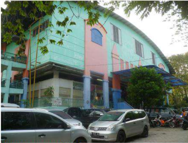
Sisi bangunan pasar yang menghadap Timur
