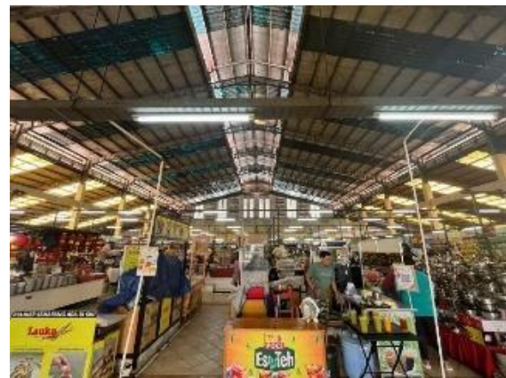
Gambar 5. Skylight pada area pasar
