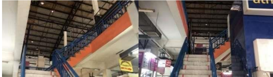
Gambar 11. Atap Tanpa Skylight Pasar Santa Sumber: Dokumen Pribadi, 2022
