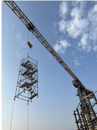
Gambar 1. Tangga scaffolding diangkat oleh tower crane
