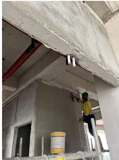
Gambar 3. Pekerjaan acian
