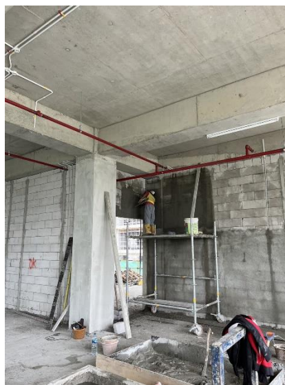
Gambar 4. Pekerjaan plester
