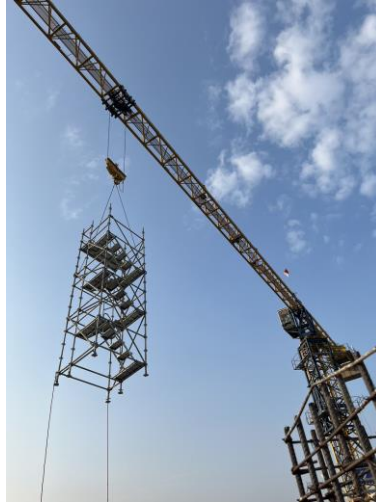
Gambar 1. Tangga scaffolding diangkat oleh tower crane
