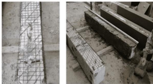
Gambar 6. Metode ferrocement pada balok bertulang (Taha et al., 2024)
