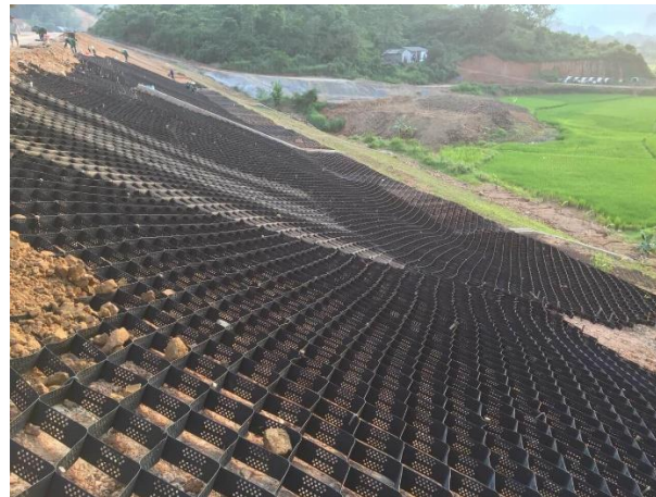
Gambar 2. Penerapan geocell sebagai perkuataan lereng
