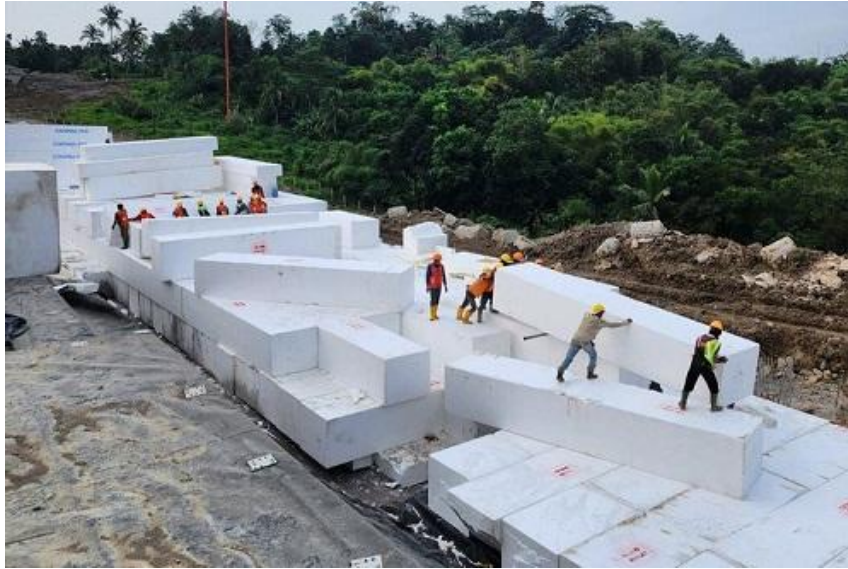
Gambar 3. Aplikasi EPS geof foam proyek Jalan Tol Cisumdawu (Tempo, 2023)
