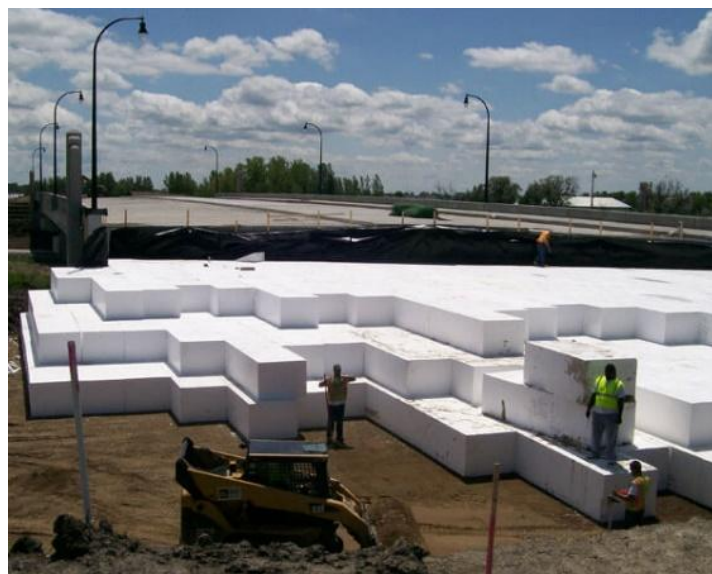
Gambar 1. Bentuk material EPS geofom (Geofom Research Center, 2011)
