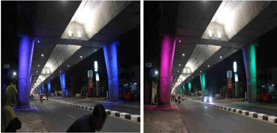
Gambar 3. Posisi lampu dekoratif yang setiap saat menyala dengan warna sama dan tidak dalam warna yang sama, karena ada kerusakan sistem kontrol.
