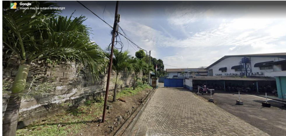
Gambar 36. Lokasi tempat pemasangan 5 set tiang luminer LED PJU setinggi 5m.
