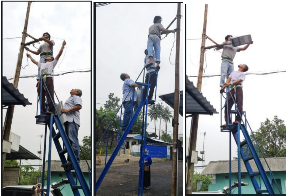
Gambar 19. Rangkaian foto pada saat persiapan dan pemasangan luminer LED PJU di lingkungan yang relevan, yaitu di lokasi mitra.
