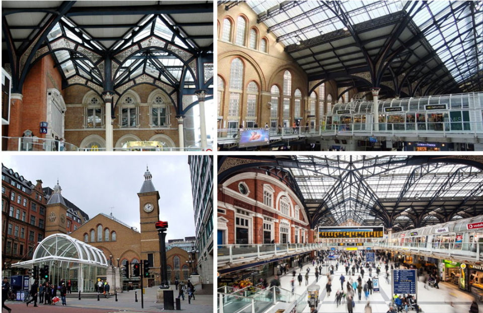
Gambar 9 – Renovasi Stasiun KA Liverpool Street, London, berupa penambahan elemen-elemen baru (kanopi, jembatan, dll.) yang diwujudkan secara kontras (bahan dan warna).
