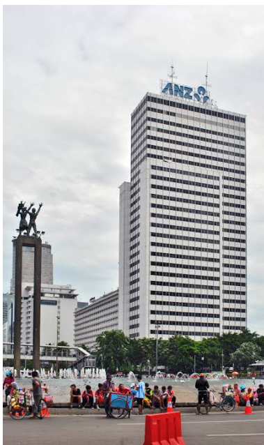
Gambar 7 – Wisma Nusantara, Jakarta, merupakan tonggak sejarah yang penting dalam perkembangan bangunan tinggi di Indonesia. Selesai dibangun pada awal 1970an, bangunan ini merupakan bangunan tinggi berstruktur baja pertama (32 lantai) di Indonesia ketika itu.
