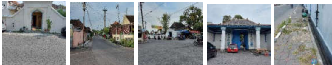
Gambar 24. Foto Kondisi Jalan Gerbang Brajanala Selatan (Sumber: Data Pribadi, 2021)
