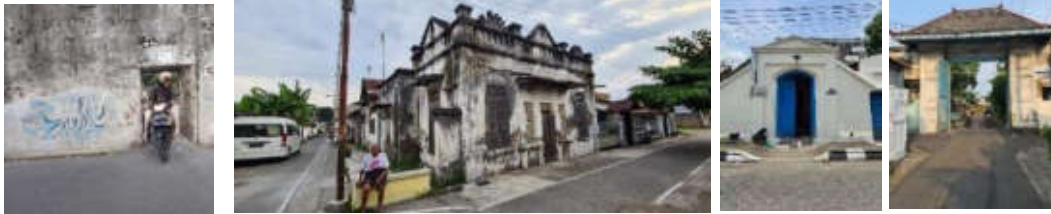
Gambar 25. Foto Material Jalan Lingkungan Baluwerti (Sumber: Data Pribadi, 2021)
