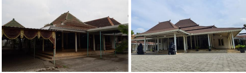
Gambar 3. (kiri) Tampak Bangunan tahun 2012 (sebelum di konservasi), (kanan) Tampak bangunan tahun 2022 setelah di konservasi Sumber: Data Pribadi, 2012, 2022
