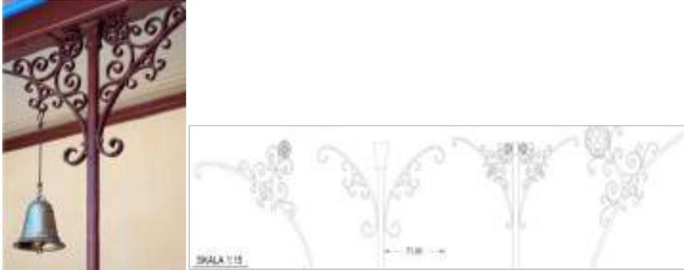
Gambar 4. 25. Detail Penyangga Balok Ukiran dari besi.
