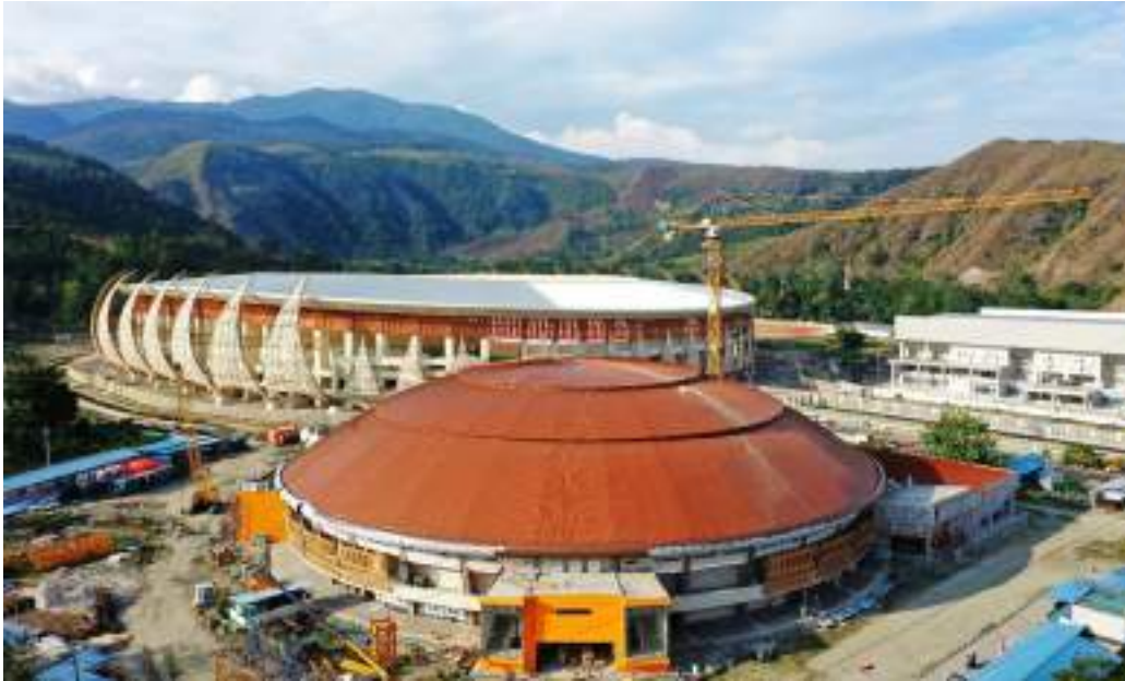
Gambar 7.9 Struktur Rangka Baja Lengkung Istora Papua
