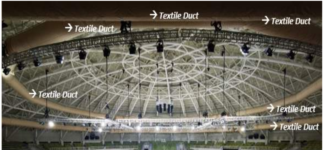
Gambar 7.14 Posisi Difuser AC dengan Textile Duct
