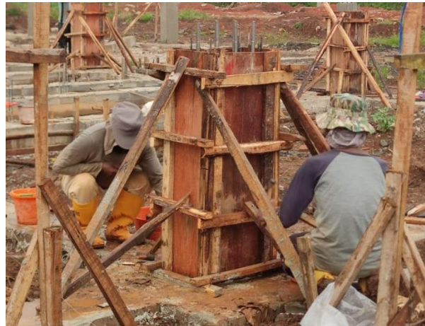
Gambar 10. Pemasangan bekisting untuk kolom pedestal
