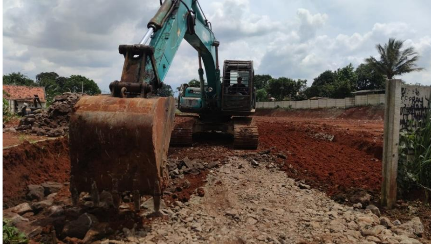
Gambar 4. Penggalian tanah dengan excavator
