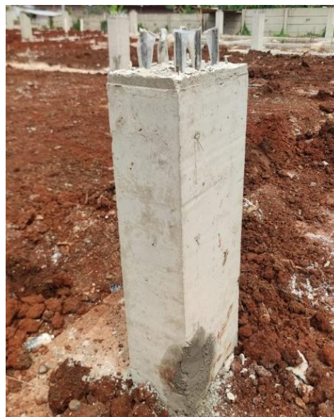
Gambar 11. Kolom pedestal yang sudah di cor
