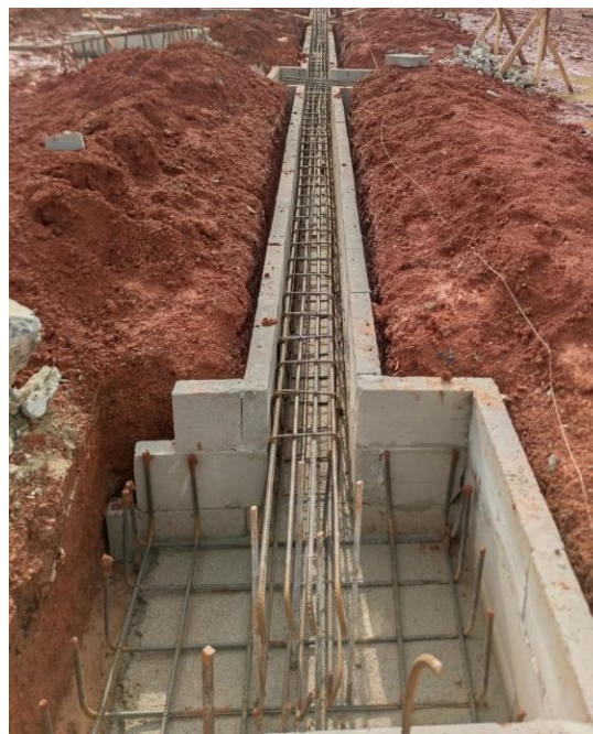
Gambar 7. Pemasangan bekisting dan penulangan untuk sloof serta pilecap
