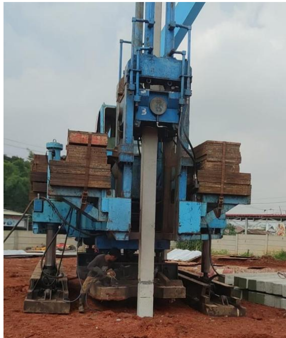
Gambar 5. Pemasangan tiang pancang dengan menggunakan HSPD
