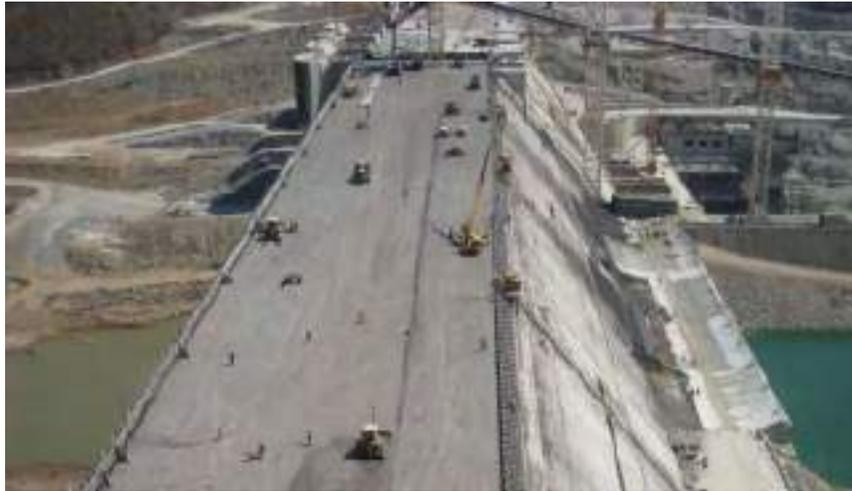
Gambar 5.1. *Mass Concrete* pada bendungan [7]
