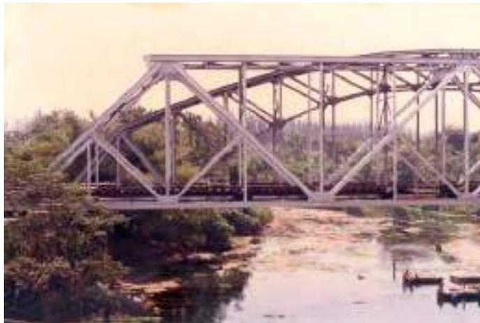
Gambar 7.3. Rangka Batang struktur jembatan [11]
