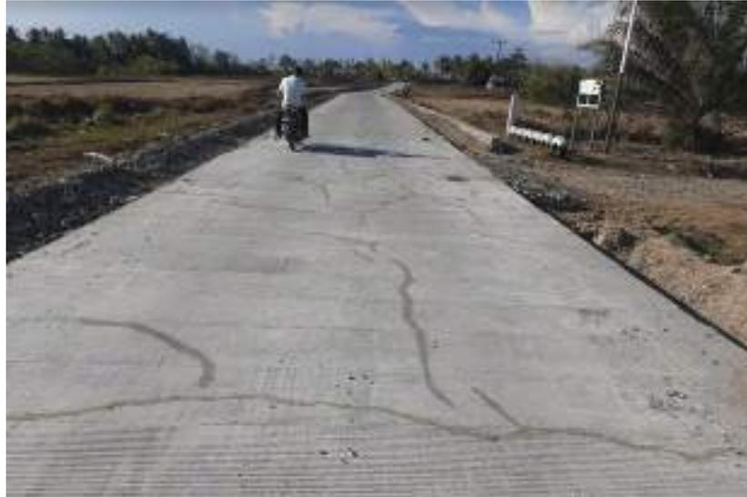
Gambar 5.2 Keretakan pada jalan beton sebelum difungsikan [8]
