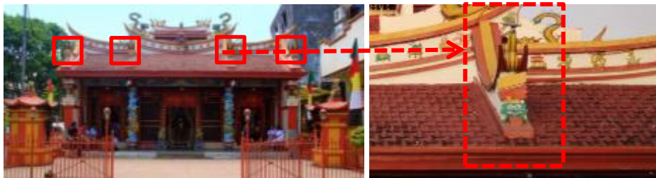
Gambar 9. Perletakkan ornamen ekor walet pada atap bangunan
