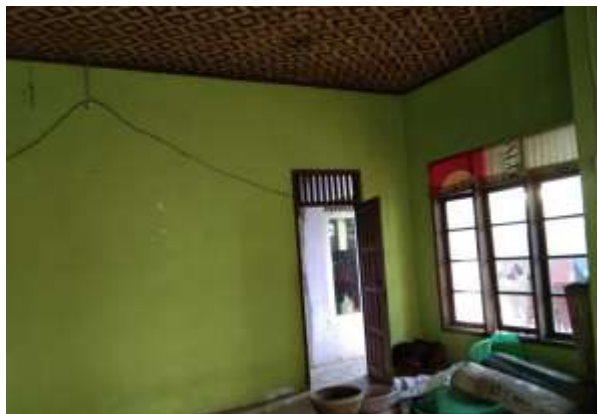
Gambar 5. Kondisi eksisting yang kurang layak pada plafon bangunan
