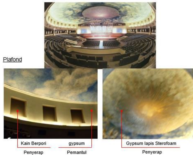
Gambar 2.3 Jenis Material Plafon pada Gedung Konser Balai Sarbini (Sumber: Kurniasih, 2018:89)
