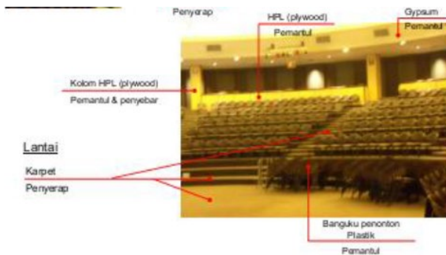
Gambar 2.4 Penggunaan Karpet pada Lantai Gedung Konser Balai Sarbini (Sumber: Kurniasih, 2018:90)
