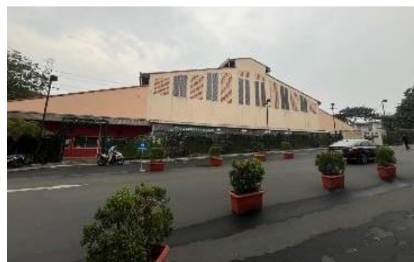
Gambar 7. Jalusi pada fasad selatan
