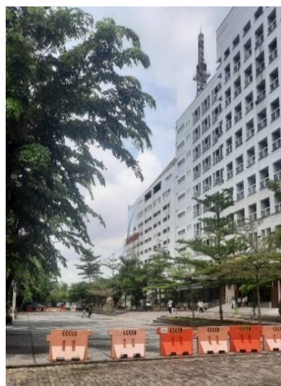
Gambar 6. Kondisi Eksisting Sumber: Dokumentasi penulis, 2025
