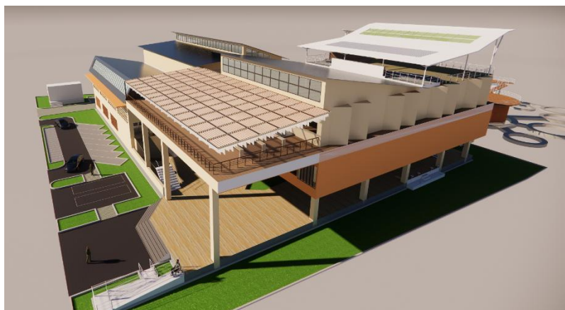
Gambar 8. Penggunaan Atap Pelana dengan Material Baja Sumber: Olahan Penulis, 2025
