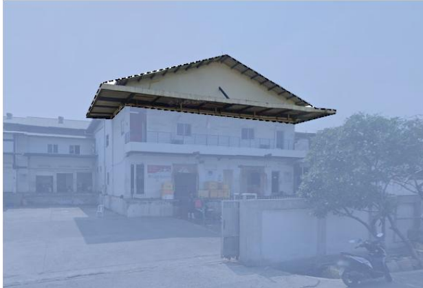
Gambar 5. Penggunaan Struktur Atap Pelana dan Material Besi. Sumber: Olahan Penulis, 2025
