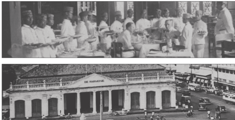
Gambar 3. Kondisi Hotel dan Bangunan Societeit de Harmonie di Simpang Harmoni Sumber: Disunting oleh Penulis, 2024
