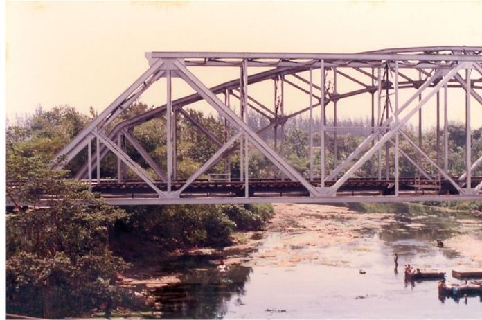
Gambar 7.3. Rangka Batang struktur jembatan [11]
